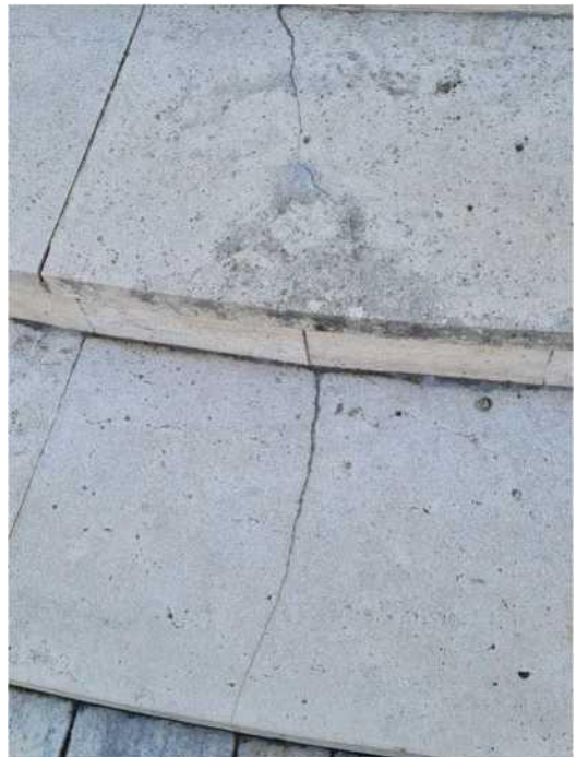
Felületi szennyeződések, átmenő repedések a főlépcső kőlapjain
