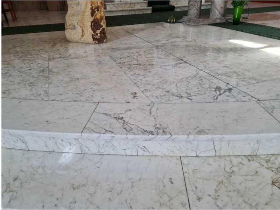
A főoltárhoz vezető lépcsősor anyagával megegyező anyagú carrarai márvány anyagú burkolólap
