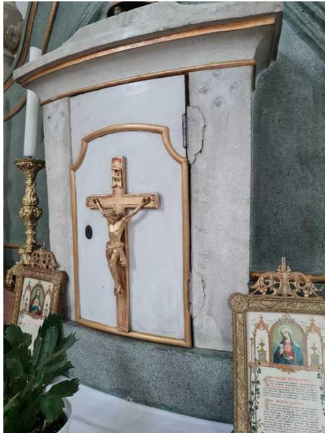
A tabernákulum műkő anyagú fedlapjának zsanérok melletti kitörései - Assisi Szent Ferenc oltár
