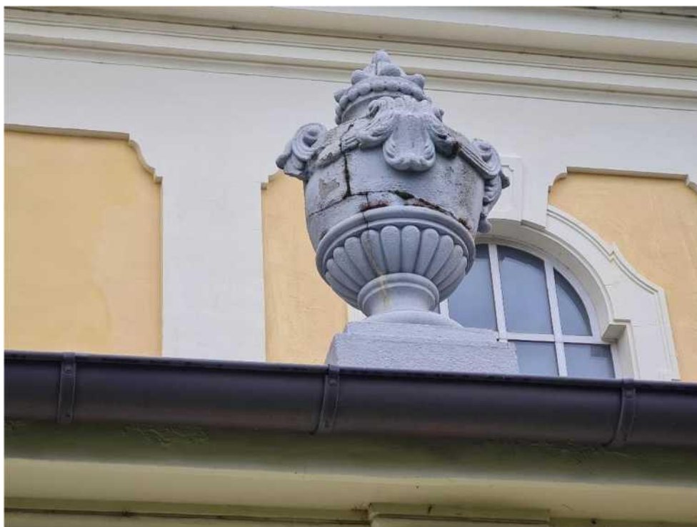
A váza dísz szerkezeti repedéseiben megtelepedő biológiai károsítók, festékréteg mállás - nyugati oldal
