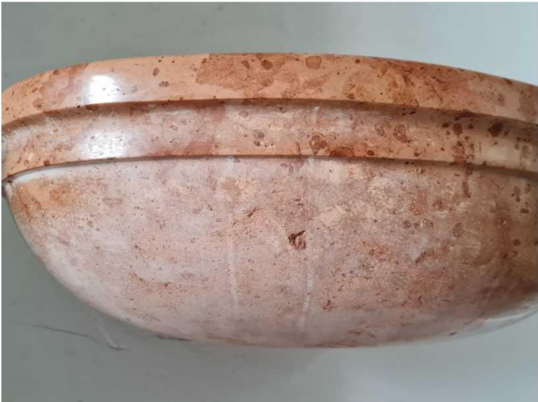
A bal oldali szenteltvíztartó felületi kopása
