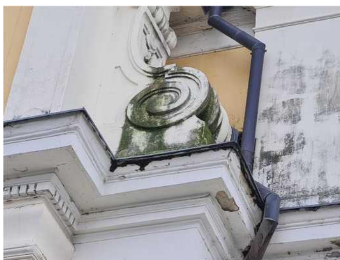
Biológiai károsítók a voluta dísz felületén - lerepedezett homlokzatfesték a párkány alján
