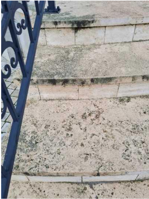
Felületi szennyeződések, átmenő repedések a főlépcső kőlapjain
