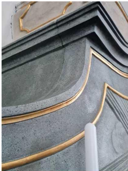
A műkőlapok illeszkedésénél található repedés - Assisi Szent Ferenc oltár
