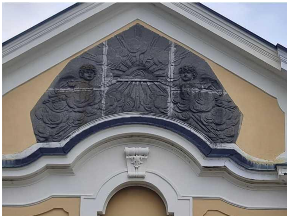
A Gondviselés szeme motívumot körbezáró kerub díszes dombormű - tisztán kivehető az elemek illesztési vonala
