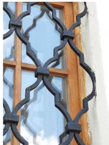
A fenti képeken látható a klasszikus neobarokk apácarács a cirkalmas pálcákkal és a négyzetes bundolásokkal. A keret beépítve a falba a vakolat alá.
