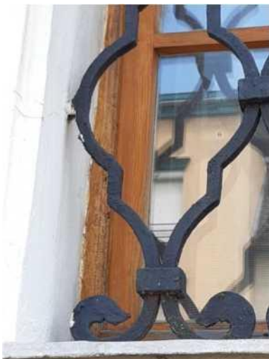
A fenti képeken látható a klasszikus neobarokk apácarács a cirkalmas pálcákkal és a négyzetes bundolásokkal. A keret beépítve a falba a vakolat alá.
